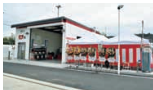
恵那給油所にピットを新設
