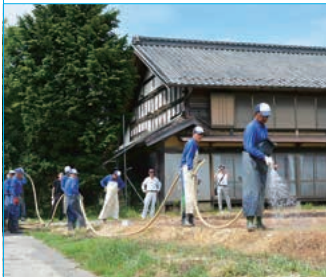
センチピートグラス種子の吹き付け作業
