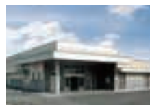
中央ホール 中津川市茄子川堤下2040 TEL0573-78-3263
