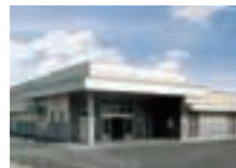
中央ホール 中津川市茄子川堤下2040
