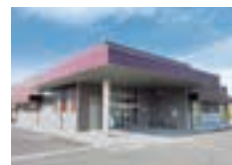
中央ホール 中津川市茄子川堤下2040
