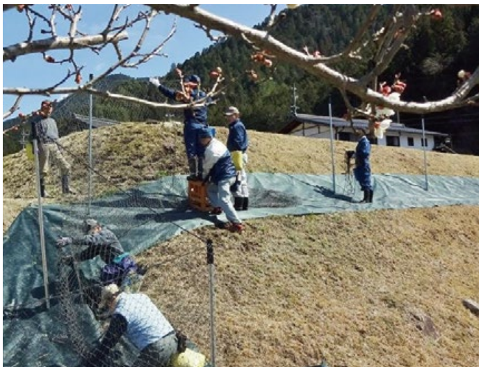
柵設置の様子
